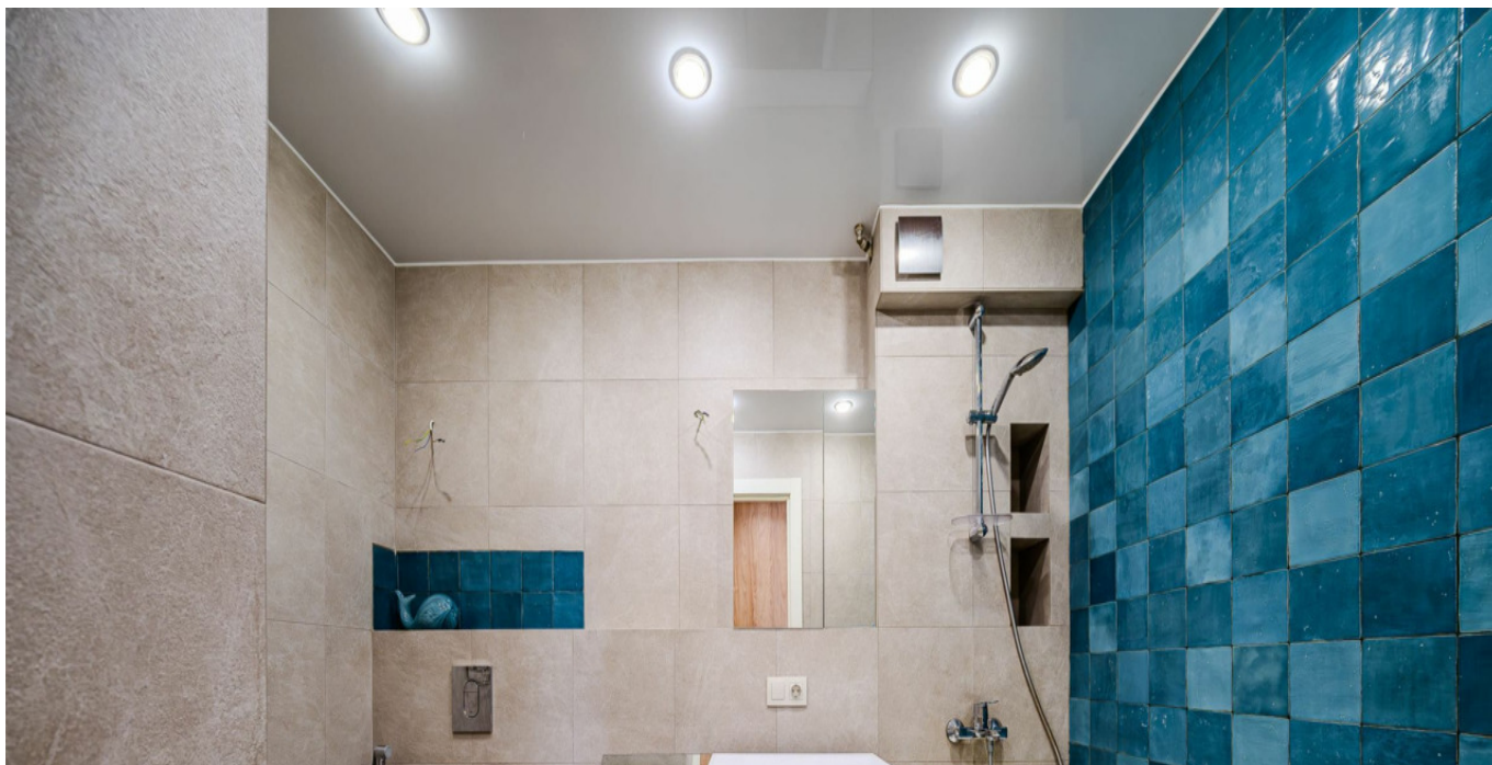
Просторный санузел, капитальный ремонт квартиры 2021 года
